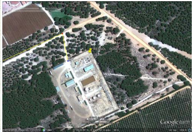
Imagen aérea de la planta de proceso Repsol Poseidón.
