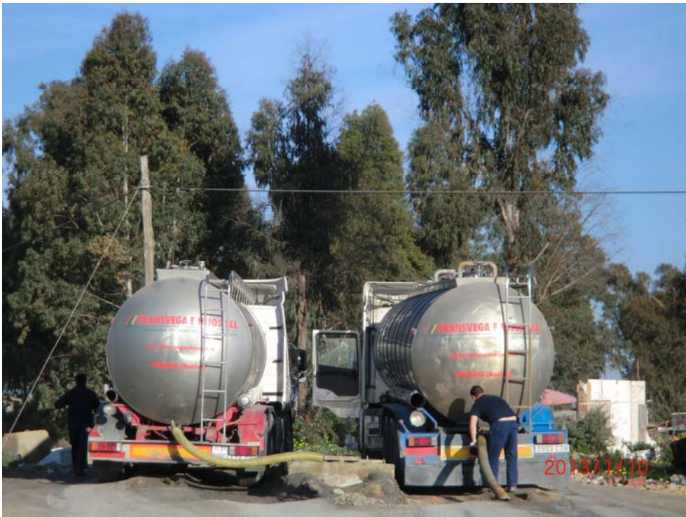
Vertido en camiones cisterna en arqueta de la red de saneamiento de la ciudad de Huelva (+18.000 al año)
