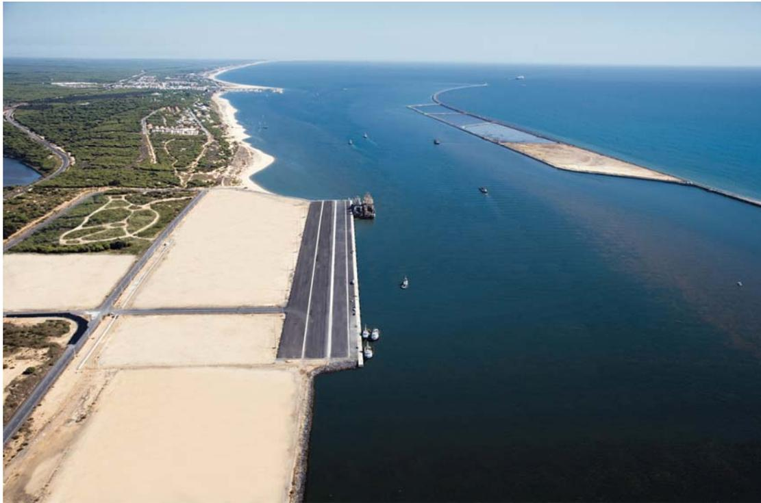
*Recinto de rellenos de dragados y ampliación de muelles del Puerto tras extender una capa de arena.*
